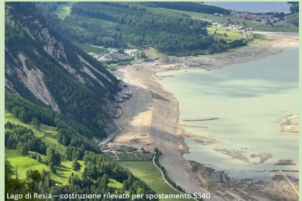
Lago di Resia – costruzione rilevato per spostamento SS40
